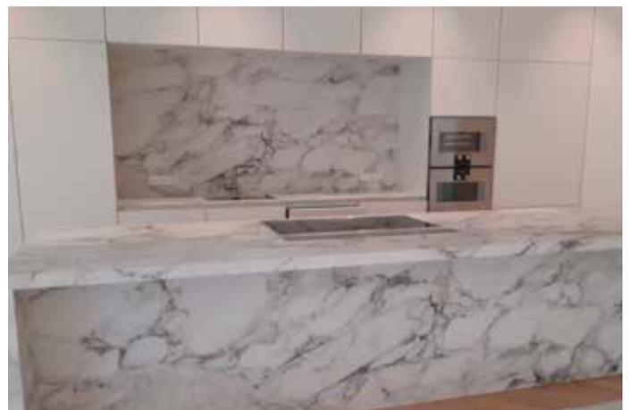
Keramik Marazzi Calacatta mit satiniertes Oberfläche. Die Arbeitsplatte und Rückwand in 12 mm Stärke. Sämtliche Teile der Insel wurden auf Gehrung gefertigt, d.h. auch die Wangen und die Untersicht der Insel sind auf Gehrung gearbeitet. Dadurch wirkt die Küche wie ein massiv gehauener Block.
