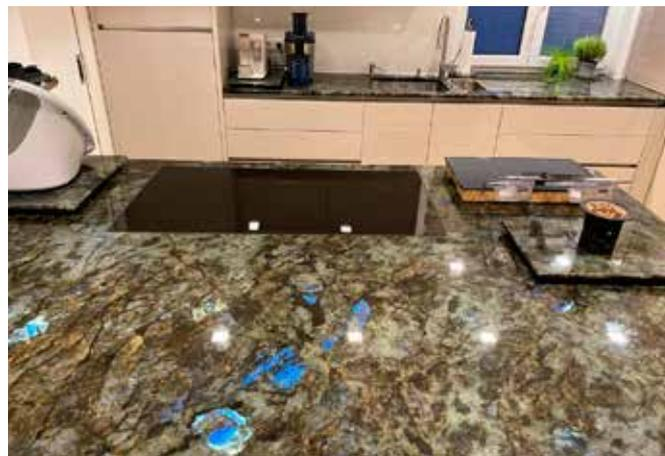
Küchenarbeitsplatte aus Quarzit Labrador Madagaskar in 3 cm Stärke und polierter Oberfläche, rechts im Bild ein Untersetzer für den Esstisch aus demselben Material
