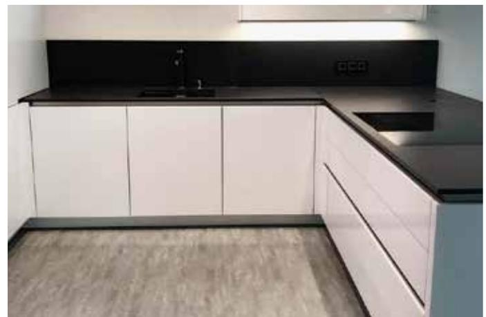
Dekton Domoos, 2 cm, mit flächenbündig eingebautem Kochfeld, Unterbauspüle und poliertem Ausschnitt sowie Rückwand aus demselben Material
