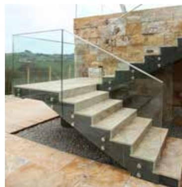
Außenstiege aus gelbem Travertin. Besonders harmonisch wirkt die Kombination mit Steinverbler aus demselben Material. Auch die Metallstiege wurde mit grossformatigen Travertinstufen belegt.
