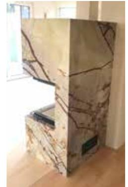
Der Strukturverlauf der Rohplatte wurde bei der Verarbeitung komplett integriert. Zusätzlich wurden die Seitenteile und Kamineinfassung auf Gehrung gefertigt. Durch die markante Zeichnung des Materials wirkt der Kamin wie ein abstraktes Kunstwerk.
