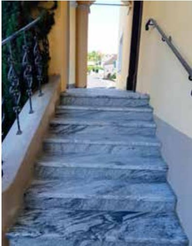
Die Trittstufen und Spiegel wurden im Grossformat aus dem Granit Viscont White gefertigt. Durch die geschmackvolle Restaurierung erstrahlt der Eingang des Herrenhauses in alter und neuer Schönheit.
