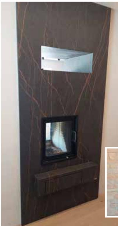
Dieser Raumkamin wurde mit Dekton Laurent verkleidet; auf Gehrung und strukturverlaufend verklebt. Auch auf der Außenseite wurde dasselbe Material verwendet und mit Natursteinverblender abgerundet. Schönes Detail: Die integrierte Aufbewahrungslade.
