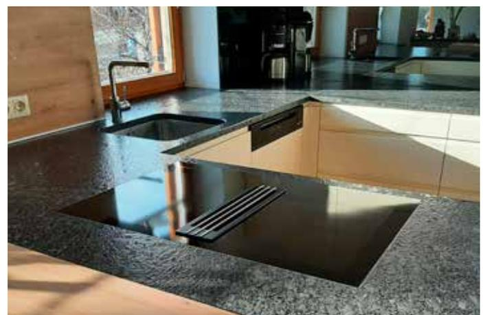
Küchenarbeitsplatte aus Granit Steel Grey mit leatherstyle Oberfläche in 2 cm, Unterbauspüle und flächenbündig eingebautem Kochfeld
