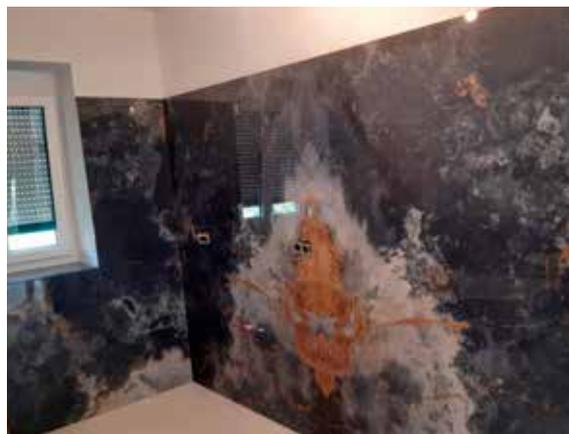
Die Duschwände und dieses Badezimmer wurden mit dem keramischen Material Infinity Blue Ocean veredelt. Der eindrucksvolle Effekt der gespiegelten Großformatplatten wird auch Butterfly genannt.
