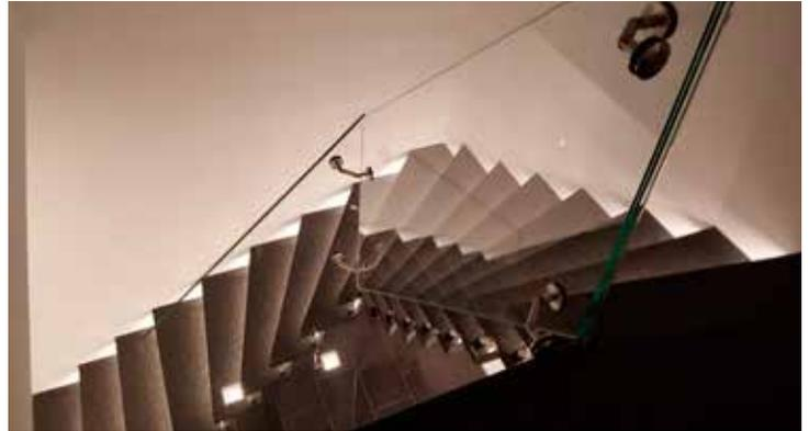
Die Steinstiege aus Granit Impala wurde „freitragend“ montiert. Auf der Unterseite flächenbündig eingefräste LED-Streifen erzeugen ein herrliche indirekte Beleuchtung und setzen die Stiege in Szene.
