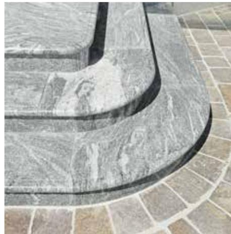
Das Eingangspodest und der Zugang mit zwei Stufen aus Granit Verde Marina wirken mit dem abgesetzten Halbrundstab einerseits und den Eckteilen mit großem Radius andererseits, jeweils aus einem Stück geschnitten, monumental.
